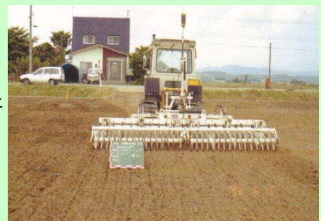
②レベラー運土
