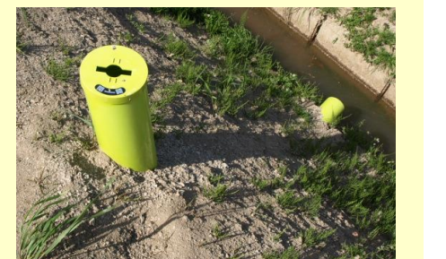
水位調整型水閘
