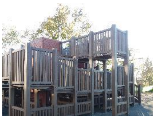
完成した大型木製遊具
