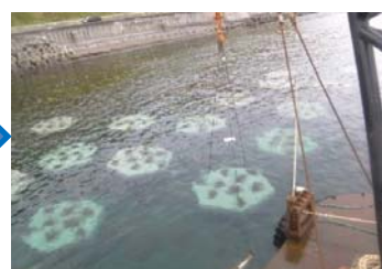
③造成海域へブロック据付
