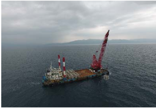
『魚礁設置工事』
