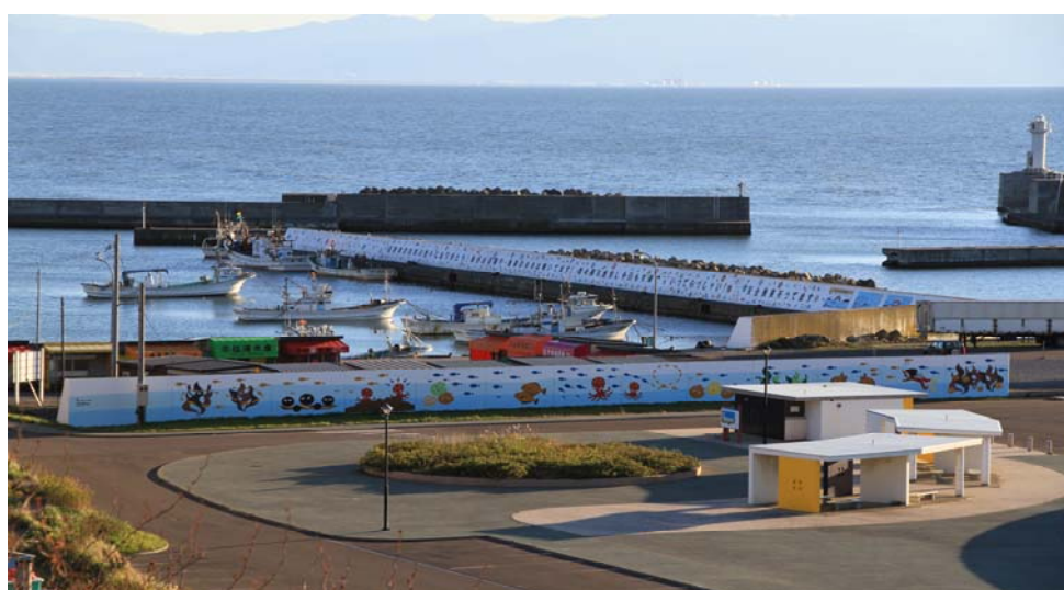
(H30実施 厚田漁港北護岸胸壁)
