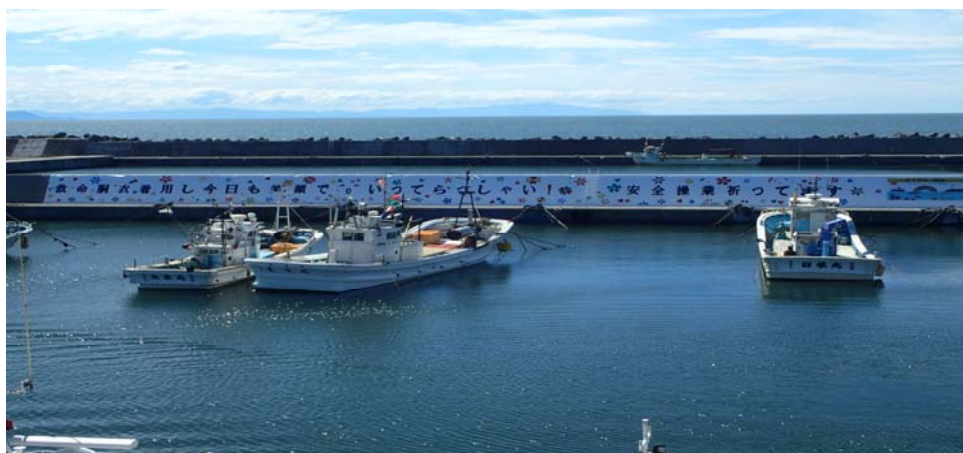
(H28～H29実施 厚田漁港新西側防波堤)
