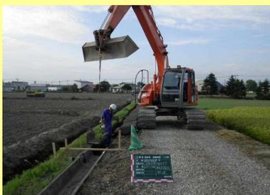
老朽化したコンクリートトラフを撤去
