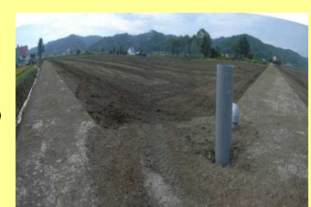
こうじご かんせい 工事後（完成）
