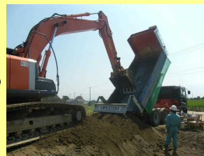
ダンプトラックに積み込んだ土を、必要な農地に、おろします
