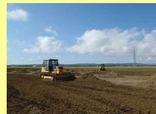
最後に、運び終わった土を、フルトラクターで均一に、ならし工事終了
