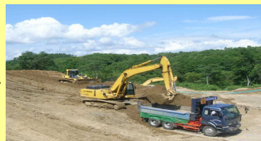
た ばしよ 他の場所から、ダンプトラックで土を積みこみ、土が必要な農地に運びます
