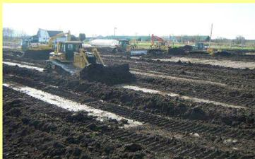
表土と呼ばれる作物が生育するのに必要な部分の土を剥いで堆積します
