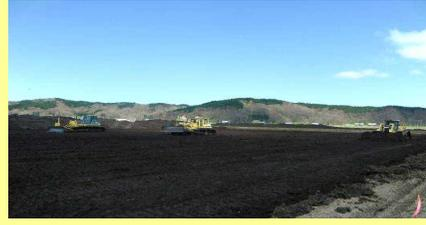
表土の下の基盤と呼ばれる部分の土を、フルターナーなどで基盤の切り盛りをし、農作業のしやすい形にします
