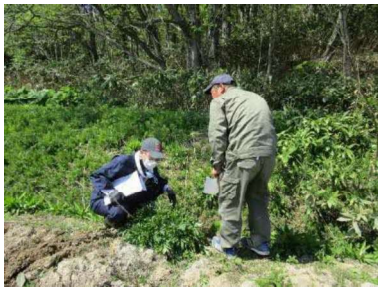
施工の深さを確認
