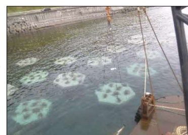
③造成海域へブロック据付
