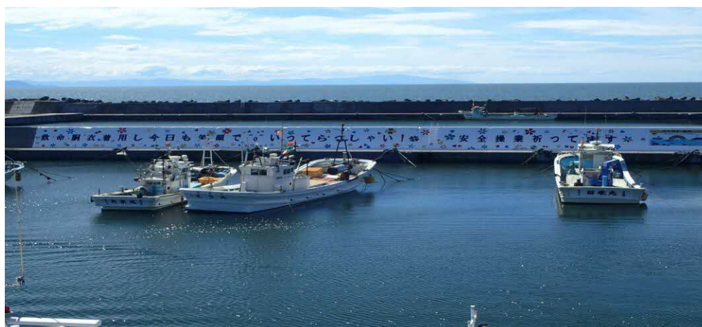
(H28～H29実施 厚田漁港新西側防波堤)
