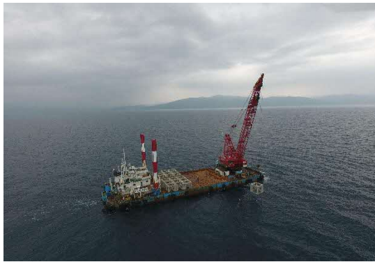
『魚礁設置工事』
