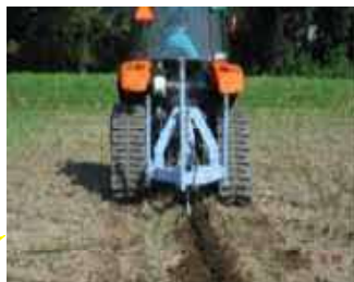
カットドレーン施工
