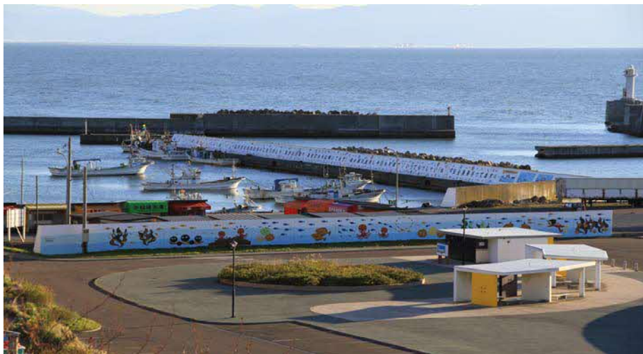
(H30実施 厚田漁港北護岸胸壁)
