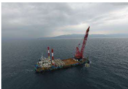
『魚礁設置工事』
