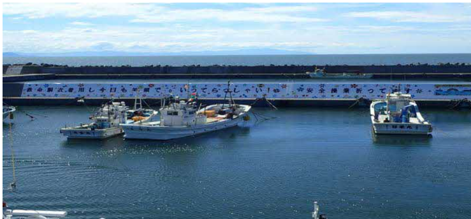
(H28～H29実施 厚田漁港新西側防波堤)
