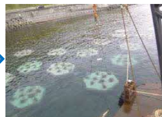
③造成海域へブロック据付
