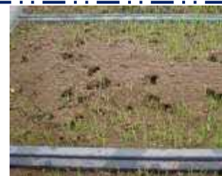
写真5 覆土の持ち上がり
