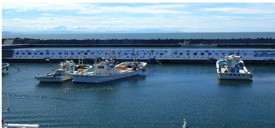
(H28～H29実施 厚田漁港新西側防波堤)
