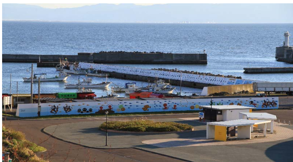
(H30実施 厚田漁港北護岸胸壁)
