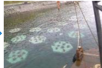
③造成海域へブロック据付
