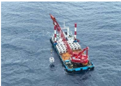
『魚礁ブロック設置状況』
