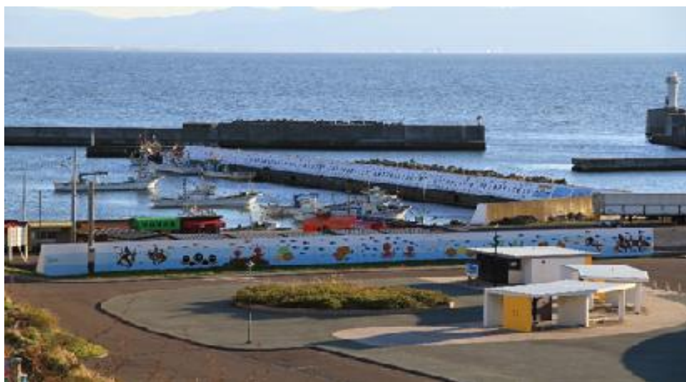
(H30実施 厚田漁港北護岸胸壁)
