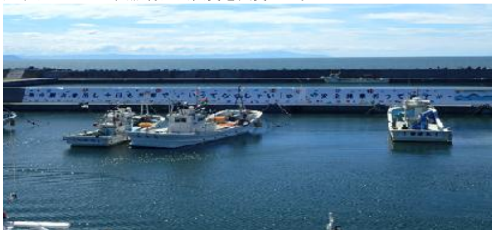
(H28～H29実施 厚田漁港新西側防波堤)
