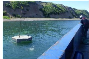
③造成海域へブロック据付
