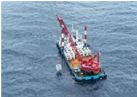
『魚礁ブロック設置状況』
