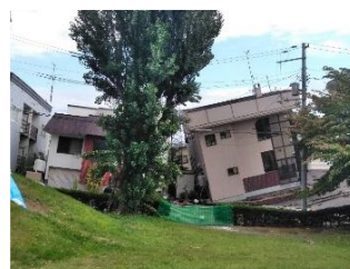
胆振東部地震による被害（札幌市清田区）
