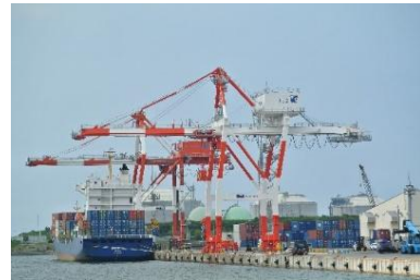
花畔埠頭（ガントリークレーン）
