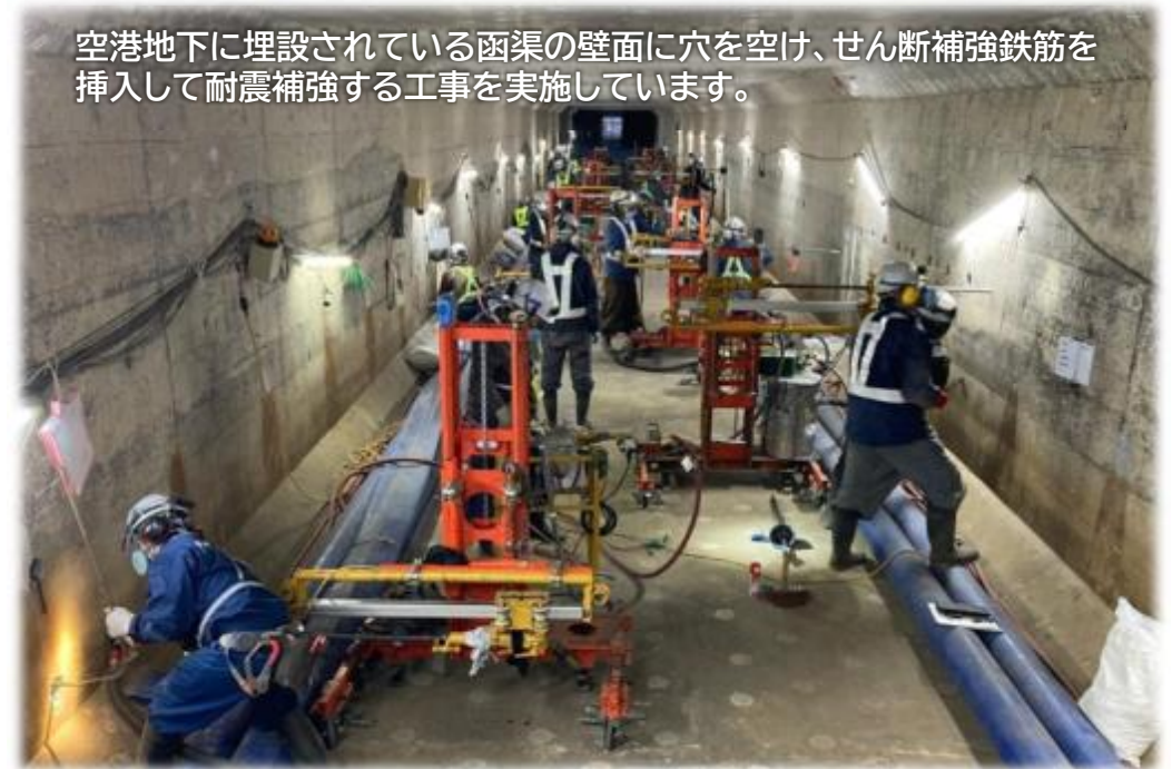
【美沢川函渠耐震補強 施工状況】
