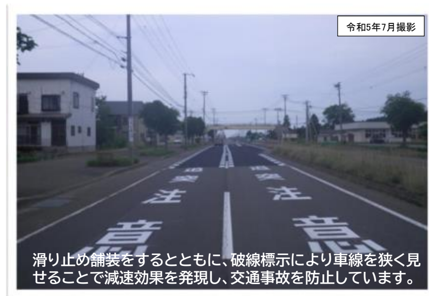
【事故対策後】国道12号 町道16号線交差点改良事業(奈井江町) (滑り止め舗装、減速路面標示等)
