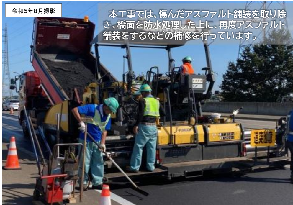
【国道36号恵み野こ線橋の橋梁補修(恵庭市)】
