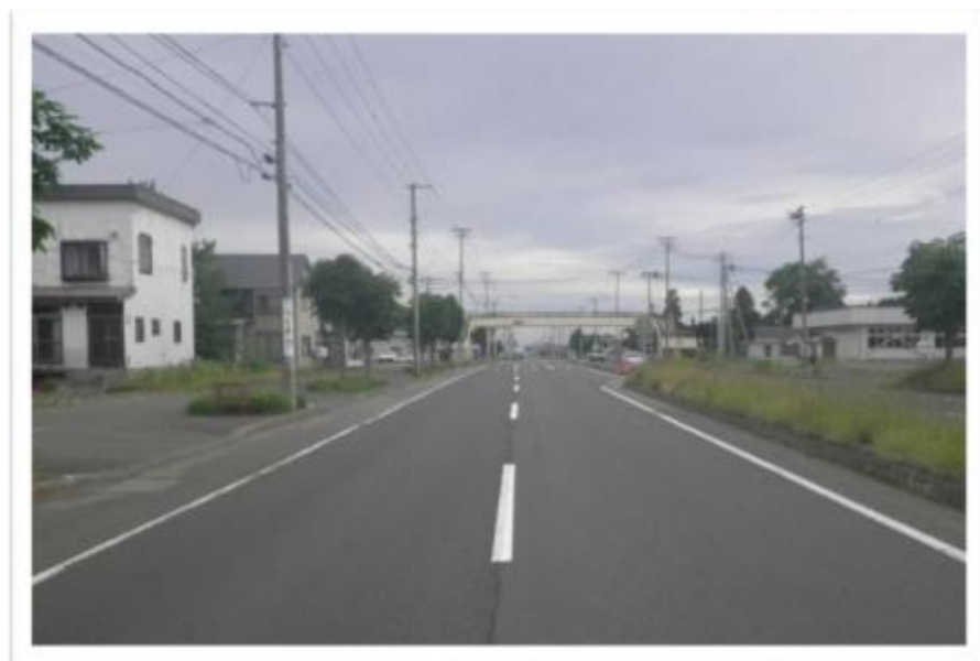
【事故対策前】国道12号 町道16号線交差点改良 交差点改良事業(奈井江町)
