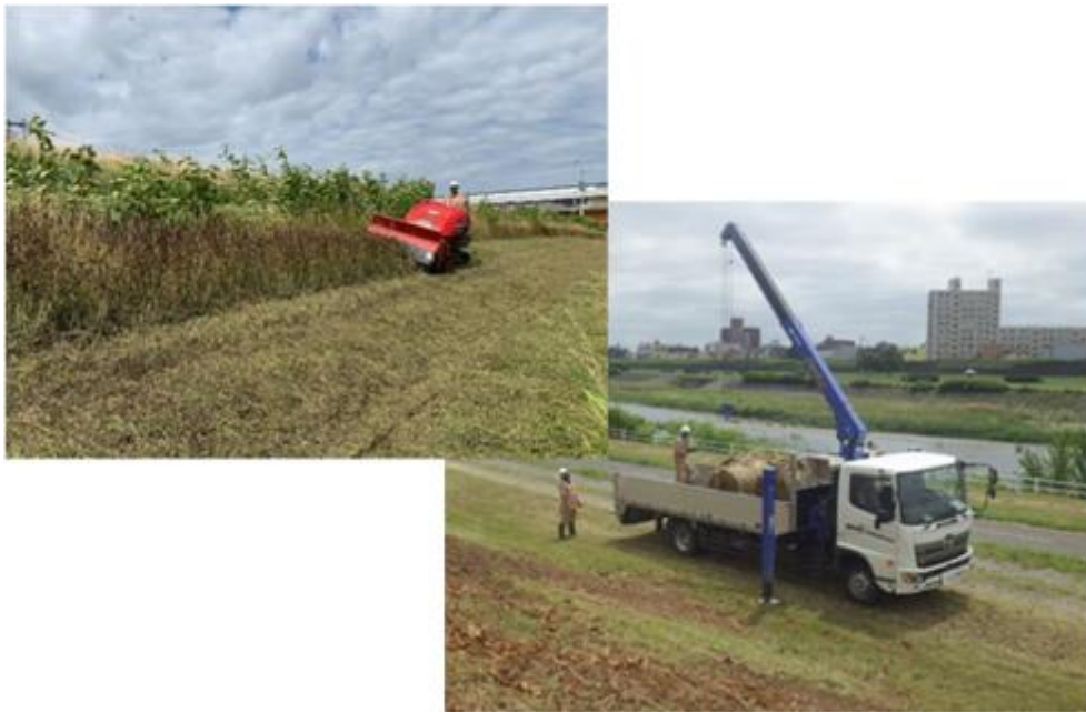
【堤防の維持管理のための除草・集草と配布(札幌市)】
