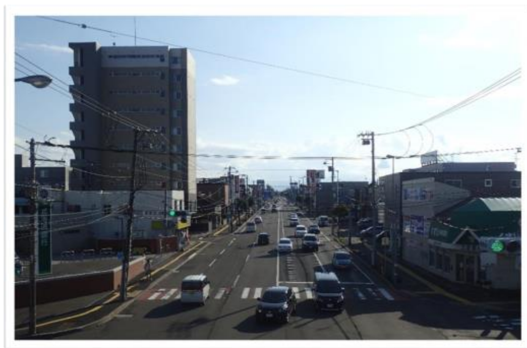
【整備前】(国道12号江別市野幌町)
