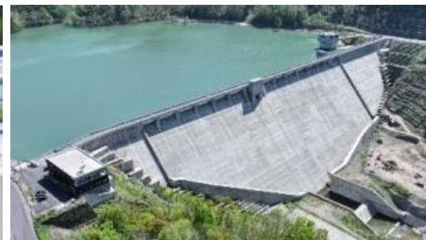
直轄初の同軸かさ上げをした新桂沢ダム
