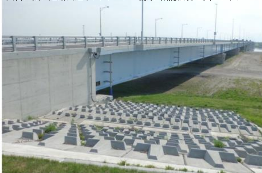
【道路構造物の流失防止対策(橋台の護岸整備)】
