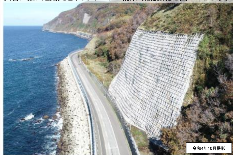
【土砂災害防止対策(国道231号 斜面对策の整備)】
