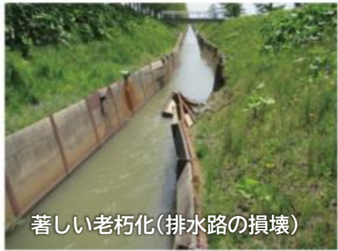
【農業水利施設(排水路)の整備】
