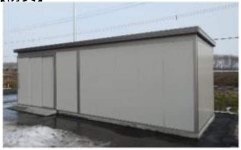
災害時における防災備蓄倉庫の整備 (北欧の風道の駅とうべつ)
