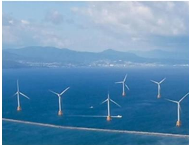
洋上風力発電の導入促進 (石狩湾新港洋上風力施設)
