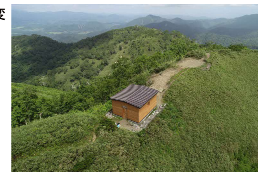
山頂付近に建つ避難小屋
