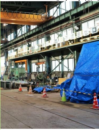
工場内部の様子
