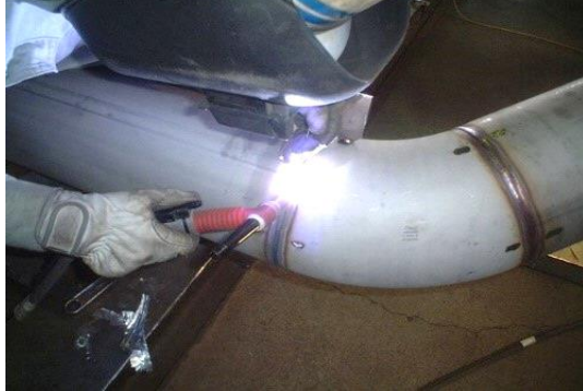
鋼管溶接(株式会社新興工業ホームページより引用)
