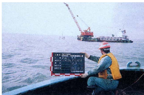
『魚礁設置工事』
