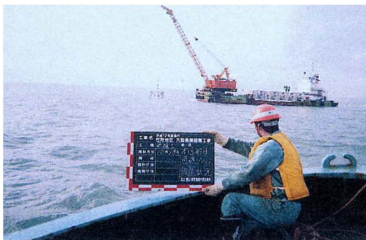
『魚礁設置工事』
