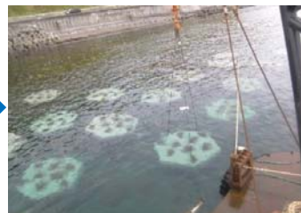
③造成海域へブロック据付
