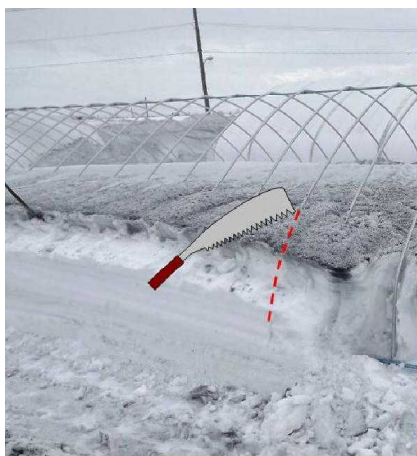
写真Ⅱ-4 肩部直管パイプまで鋸で切れ目を入れる
