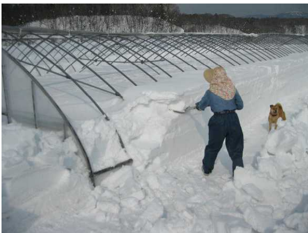
写真Ⅱ-3 人力除雪で肩部直管パイプを露出
