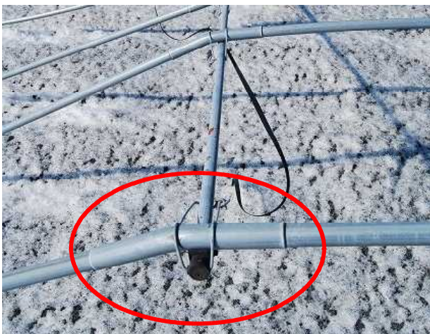
写真 I-1 棟部外ジョイント方式
