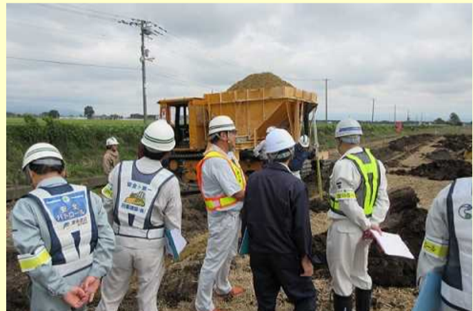
武田地区45工区工事現場の暗渠排水工事
