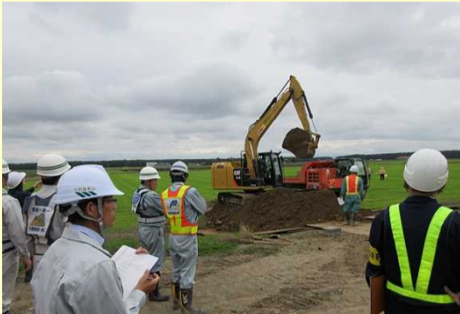
拓新地区43工区工事現場の客土工事
