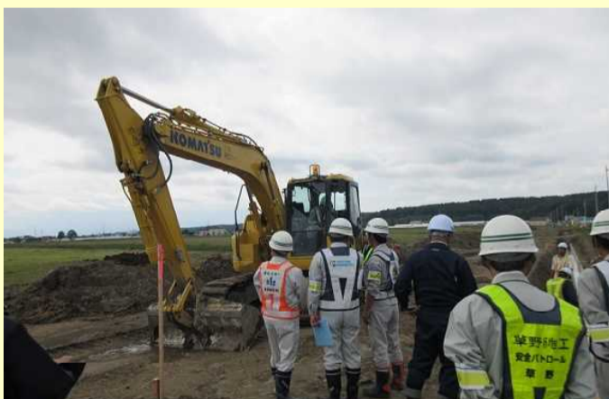
中央北地区42工区工事現場の排水路工事
